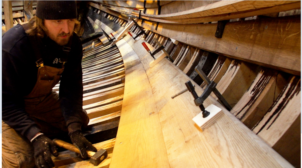
To kimmingsvæggrer monteret
